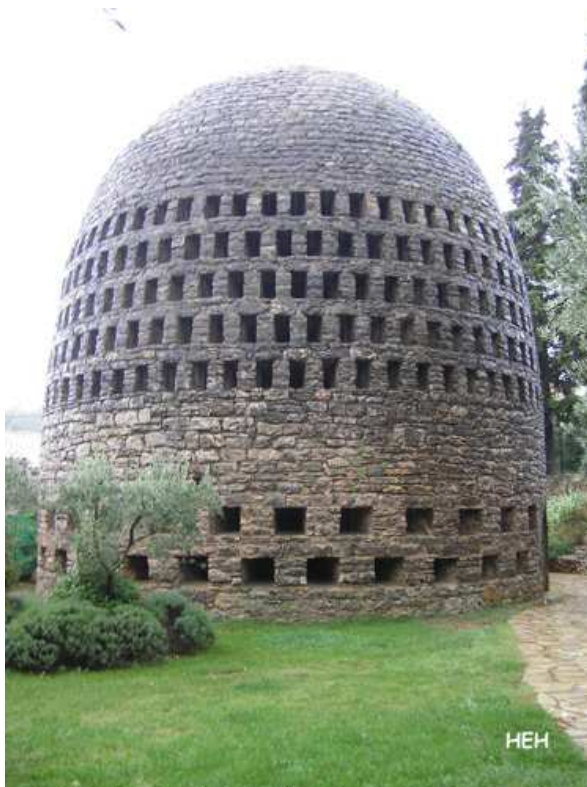
Photo (nord) de la partie extérieure du puits aérien de Trans en Provence
